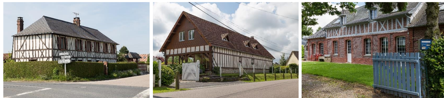
Photographie 11. Maisons à pans de bois et construction traditionnelle en briques
