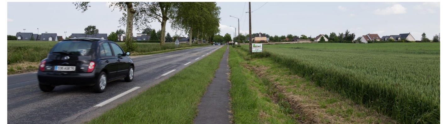
Photographie 9. Piste cyclable le long de la RD928
