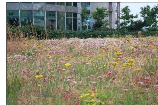
Photographie 31. Toiture végétalisée semi-intensive avec végétation prairiale
