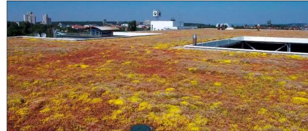
Photographie 30. Toiture végétalisée de type « extensif » à Orpins (source : Sempergreen)
