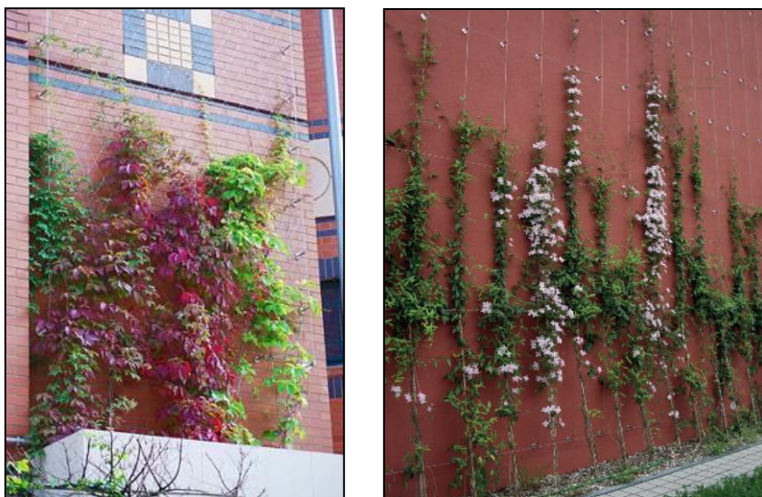
Photographie 32. Exemples de végétalisation par plantes grimpantes avec des systèmes de fixation par câbles
